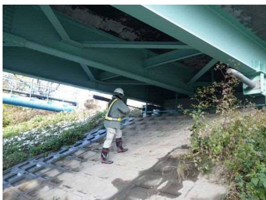
写真-3.1 専門業者による点検状況①
