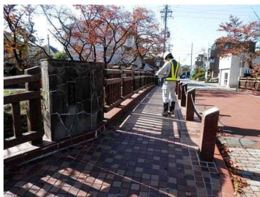
写真-3.2 専門業者による点検状況②
