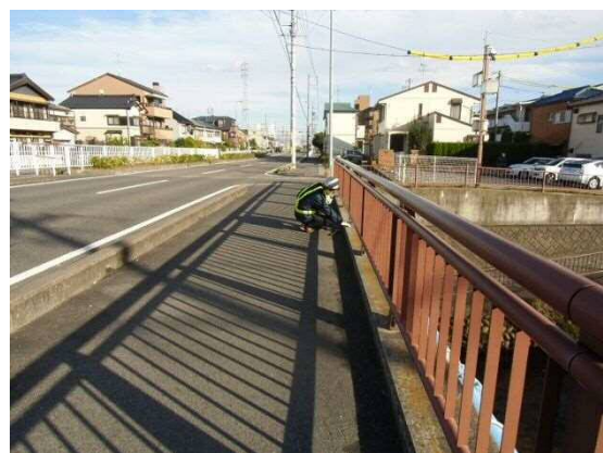
写真-3.4 職員による点検状況②
