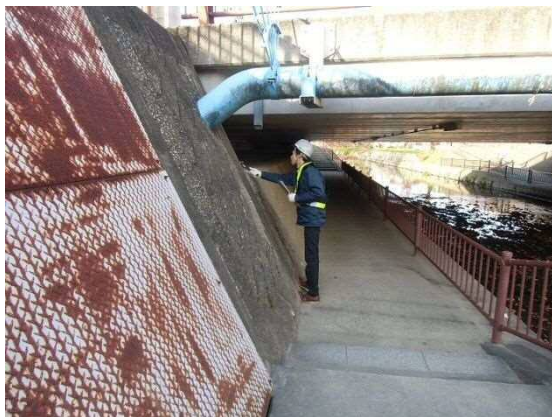
写真-3.3 職員による点検状況①
