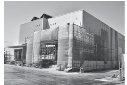
▲建設中の新学校給食センター
