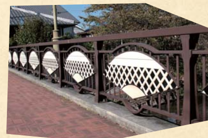
高欄に扇のデザイン 岩倉橋
