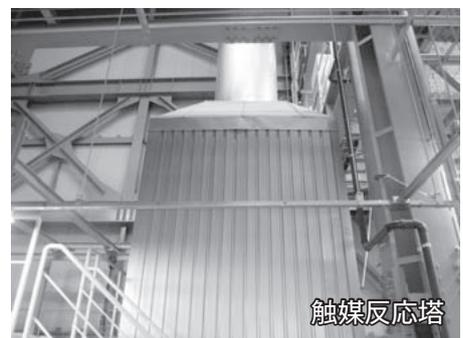
排ガス処理施設で、ばいじん、塩化水素、硫酸化合物、窒素化合物、ダイオキシン類等の有害物質を除去して煙突から排出します。
