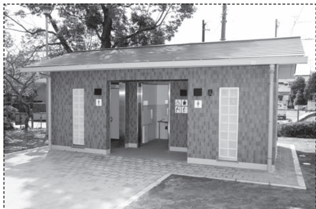
写真は御土井公園です。
