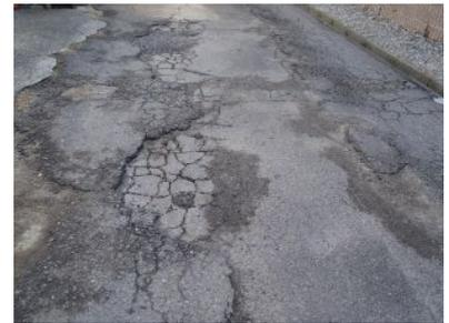
区分2（部分的なクラック、道路勾配（横断・縦断）の不良による水溜り）
