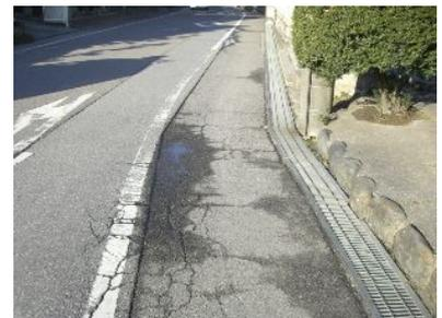
区分3（埋設物による復旧跡多し、わだち掘れ、同一路線での補修跡多し）
