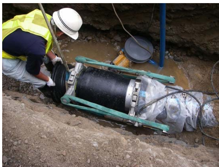
基幹管路耐震化工事の様子
