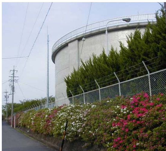
岩倉市配水場（耐震化済）
