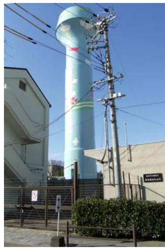
岩倉団地配水場（耐震化済）
