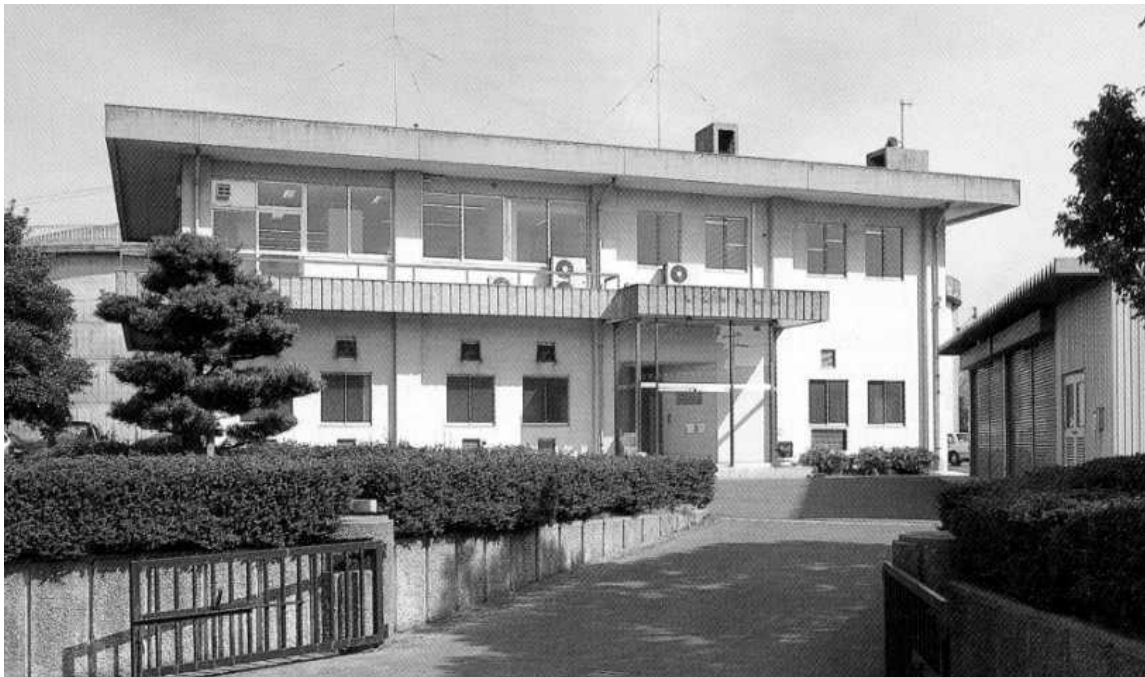
岩倉市配水場
