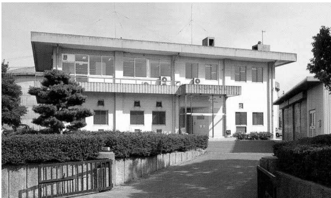
岩倉市配水場
