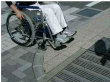
歩車道の段差改善
