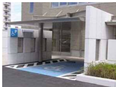
雨天時にも配慮した車いす使用者用駐車施設
