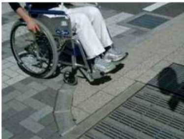
歩車道の段差改善
