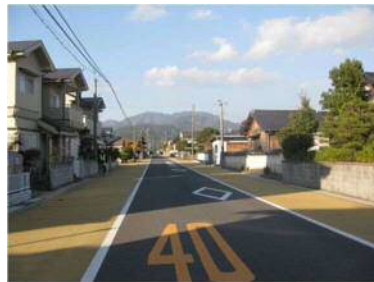
薄層カラー舗装による歩行空間の視認性向上
