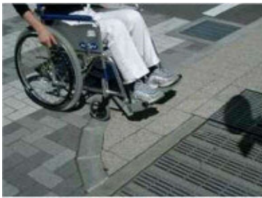
歩車道の段差改善
