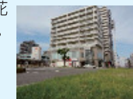
岩倉駅東地区
