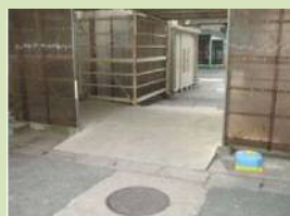
入り口の段差を解消 神奈川県横浜市立羽沢小学校
