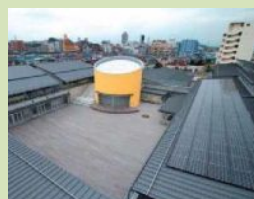
屋根に太陽光パネルを設置 東京都多摩市立多摩第一小学校
