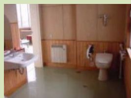
多目的トイレの設置 秋田県男鹿市立北陽小学校
