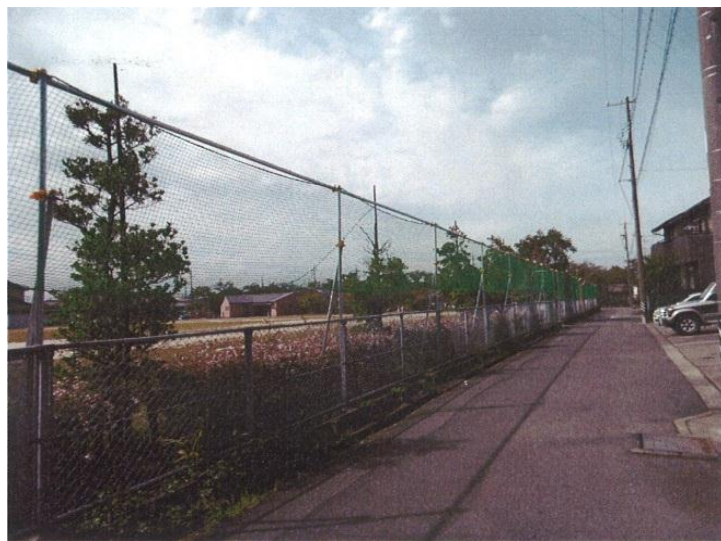
八劔憩いの広場北側のフェンス嵩上げ工事
