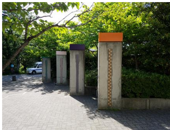
天神塚休憩所塗装修繕
