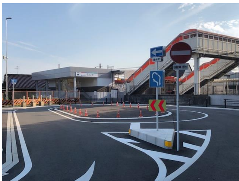
名鉄石仏駅東側周辺道路
