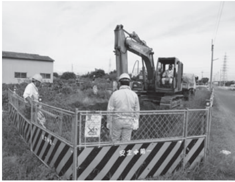
▲重機掘削の様子
