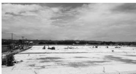
▲玉浦西地区造成工事風景です。岩沼市の防災集団移転促進事業の移転先である玉浦西地区については、昨年の8月に造成工事に着手し、被災地でいち早く住宅建築を開始できるよう着々と工事を進めています。
