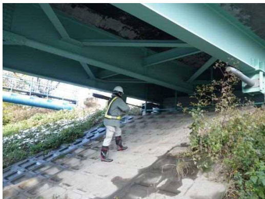
写真-3.1 専門業者による点検状況①
