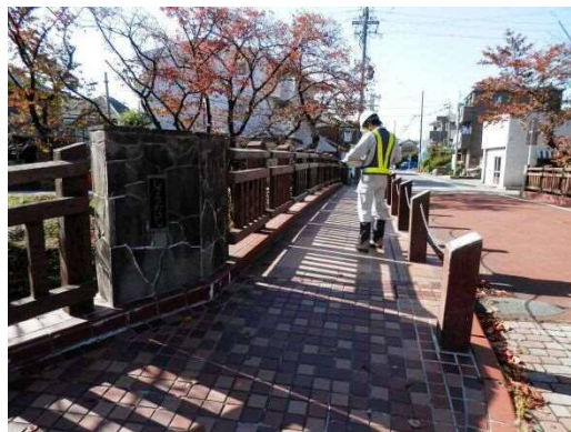
写真-3.2 専門業者による点検状況②
