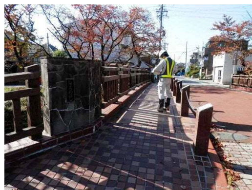
写真-3.2 専門業者による点検状況②
