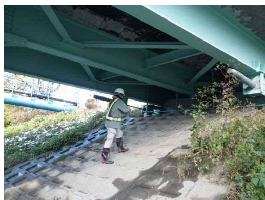
写真-3.1 専門業者による点検状況①
