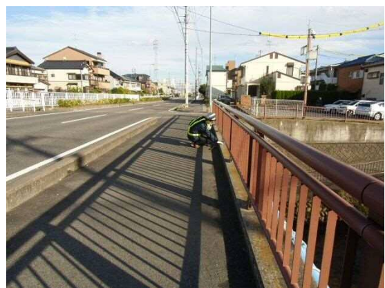
写真-3.4 職員による点検状況②
