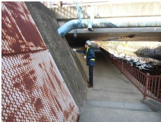
写真-3.3 職員による点検状況①
