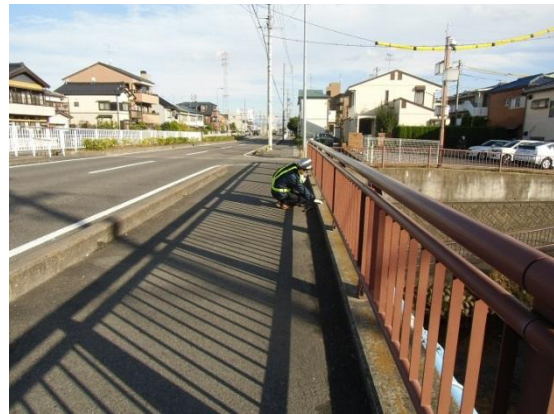
写真-3.4 職員による点検状況②
