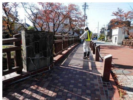
写真-3.2 専門業者による点検状況②
