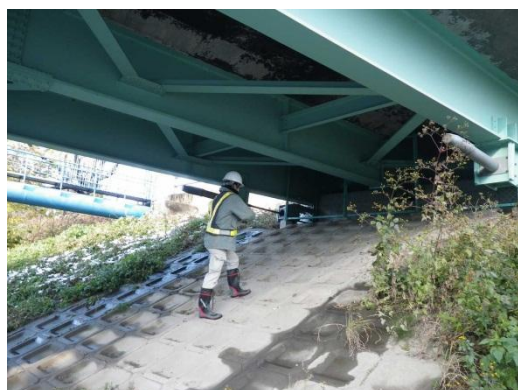
写真-3.1 専門業者による点検状況①
