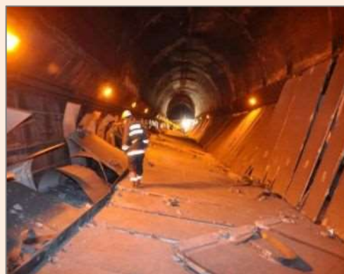
中央自動車道笹子トンネル天井板崩落事故
