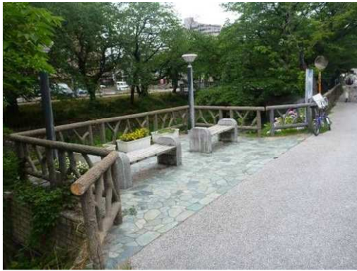
右岸休憩施設
