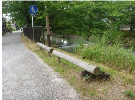
右岸休憩施設
