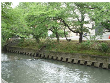
岩倉橋～豊国橋の護岸
