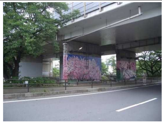
④南東から
