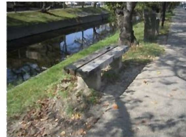
劣化が目立ちつつあるベンチ
