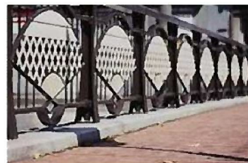
岩倉橋の高欄のデザイン 出典：岩倉市ホームページ
