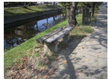
劣化が目立ちつつあるベンチ
