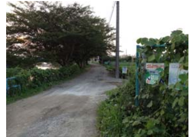
未舗装の堤防道路
