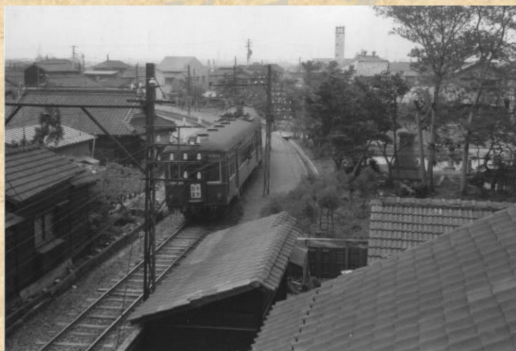
○岩倉支線 現在の神明大一社前。奥に岩倉市役所（旧庁舎）の火の見櫓が見える。
