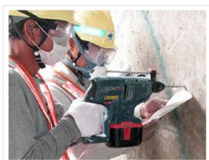
ドリル法による中性化試験
