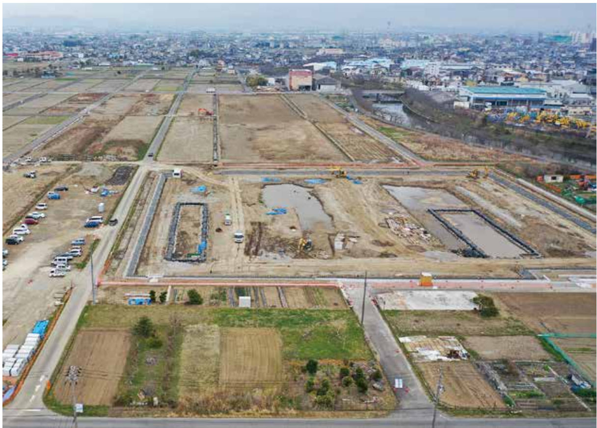
調査区全景〔調査完了〕（西から） 2021年3月撮影
