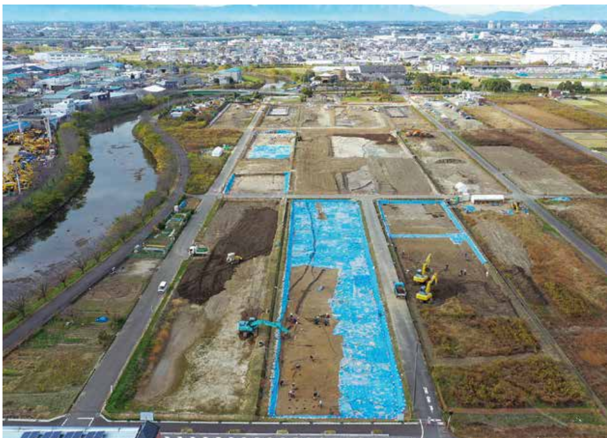
調査区全景（東から） 2020年11月撮影
