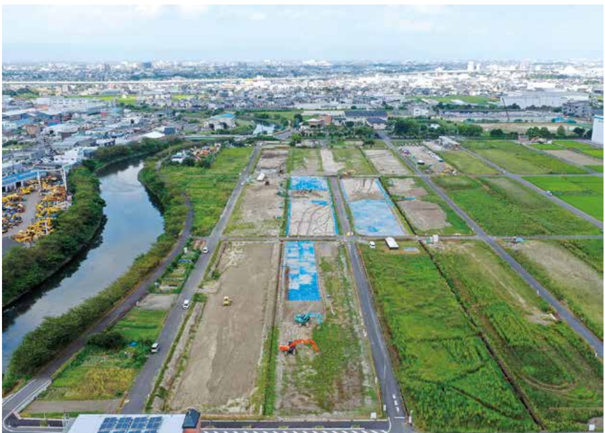
調査区全景（東から） 2020年8月撮影
