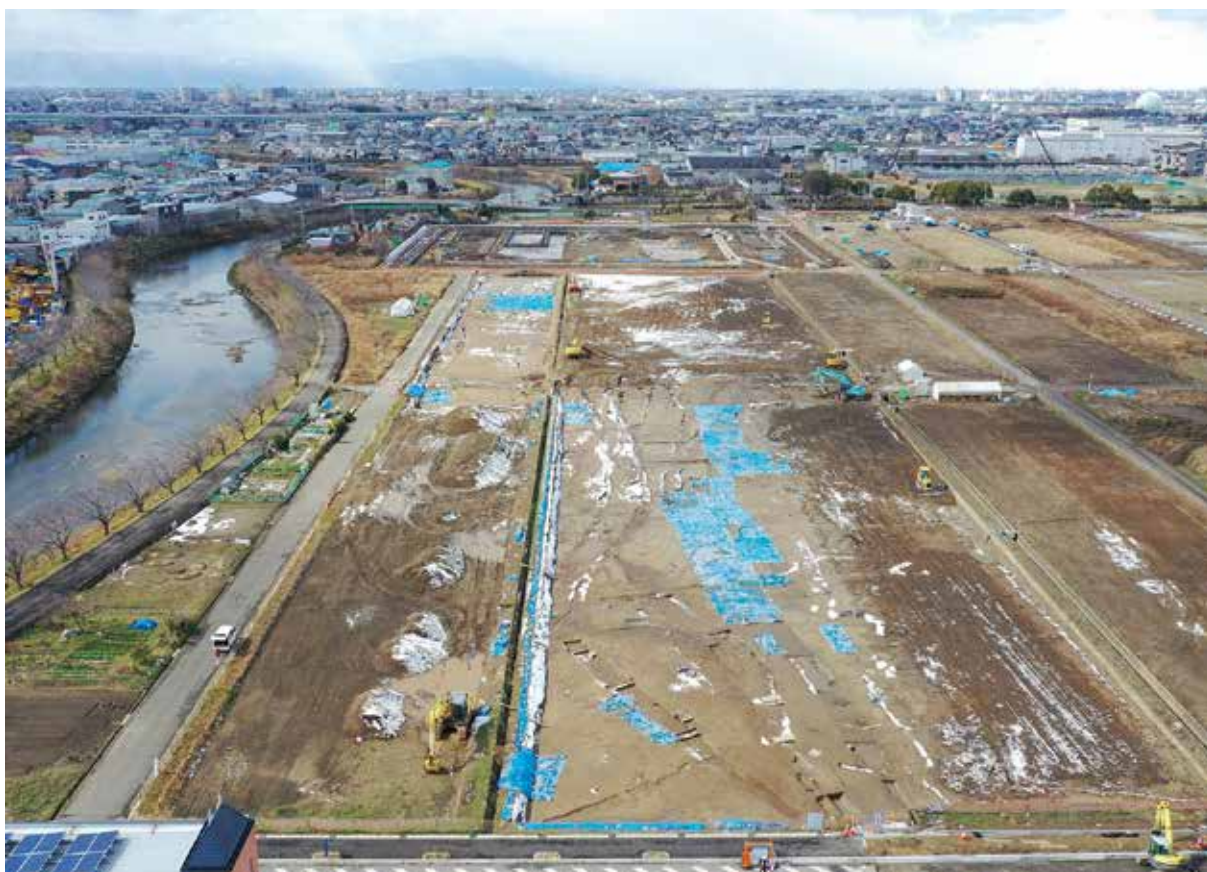
調査区全景（東から） 2021年2月撮影
