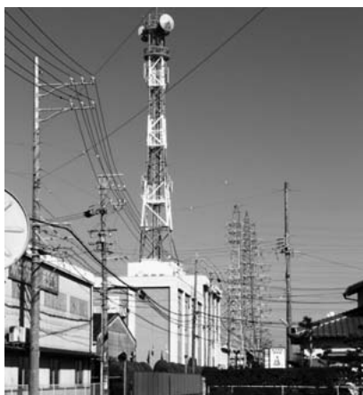
▲ 中部電力の鉄塔群
