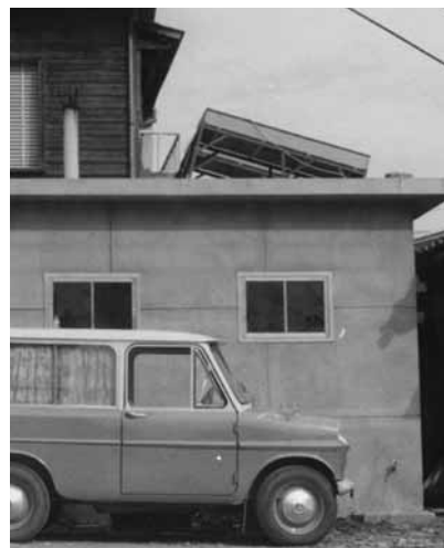
▲屋上の上に設置されている太陽熱温水器
