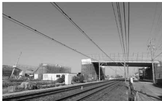
▲一宮春日井線街路改良工事の様子
