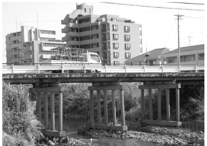
▲ 架け替え工事が行われる生田橋
