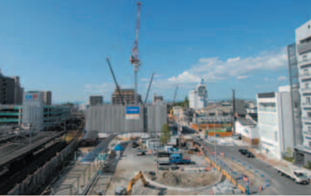
▲岩倉駅東再開発の様子（写真 は9月8日現在）
