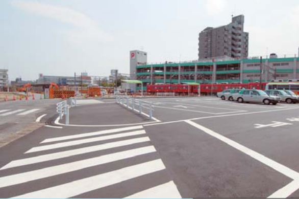
▲ 岩倉駅東地区北街区市街地再開発事業に伴う工事のため設置された仮設駅前広場。
