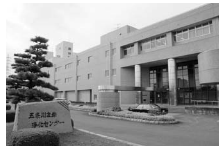
▲平成5年2月、五条川左岸公共下水道が一部供用開始
