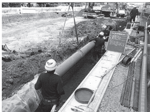
▲配水管布設工事
