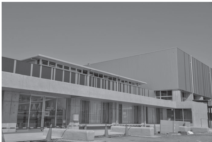
▲岩倉北小学校屋内運動場等複合施設
