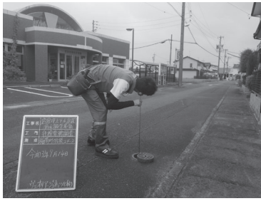
弁栓音聴調査
