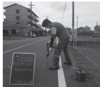
漏水確認調査
