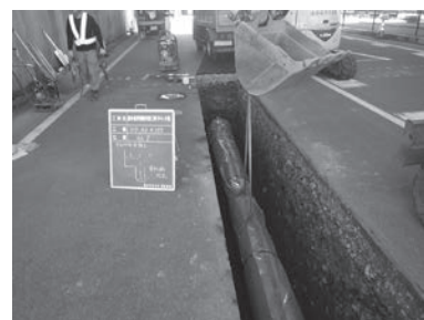
▲基幹管路耐震化工事
