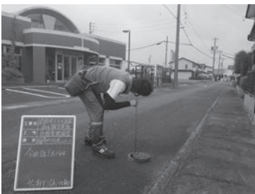
弁栓音聴調査
