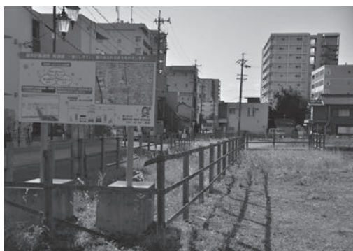
▲現在の桜通線の状況
