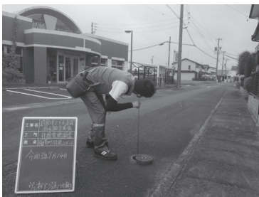
弁栓音聴調査
