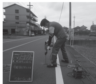
漏水確認調査
