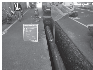
▲基幹管路耐震化工事
