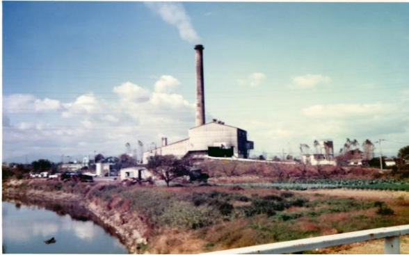
かわいちょう しよりじょう 川井町にあったごみ処理場
