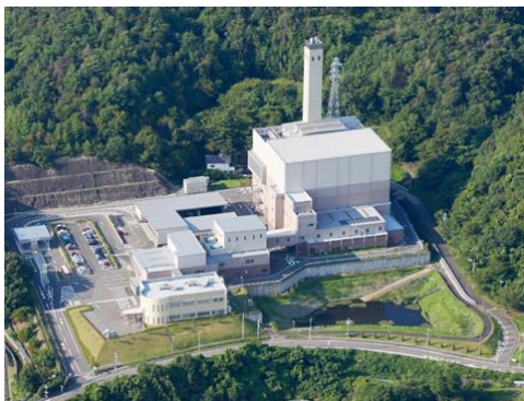
ごみ焼却場「小牧岩倉エコルセンター」
