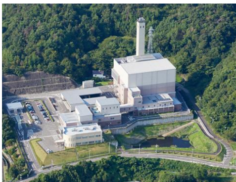
しょうきやくじょう ごみ焼却場 こまきいわくら 「小牧岩倉エコルセンター」
