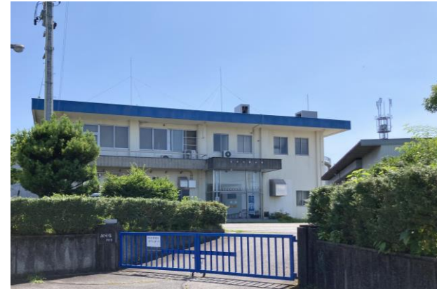
岩倉市配水場
